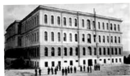
Le premier bâtiment de Darüşşafaka à Fatih, Istanbul © Darüşşafaka Cemiyeti
